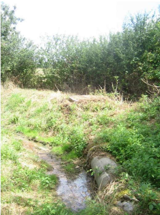
Tuyau de recueillement des lixiviats avant lagunes
